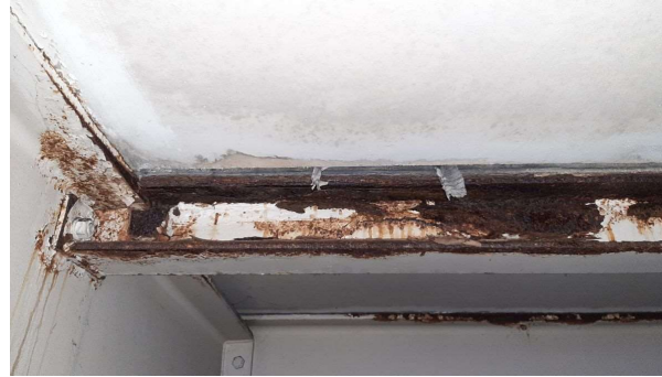
Bild 88 Rampen- und Randträger (B0725)
