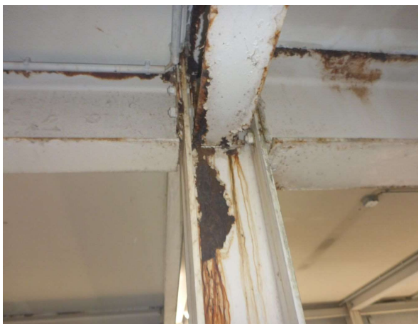
Bild 51 Stützen und Anschlüsse (B0095)
