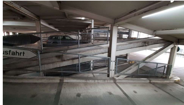
Bild 90 Rampen- und Randträger (B1530)
