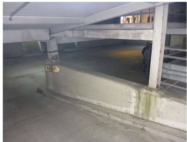
Bild 98 Rampen- und Randträger (B0939)
