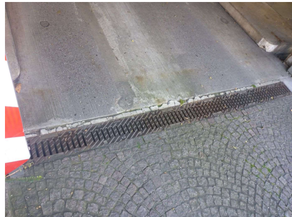
Bild 20 Träger über Einfahrt (B236)
