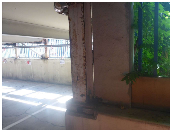
Bild 64 Stützen und Anschlüsse (B0258)
