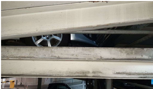
Bild 95 Rampen- und Randträger (B2148)
