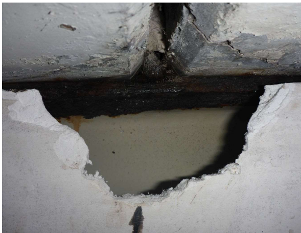
Bild 105 Querschnittsminderung (B0084)
