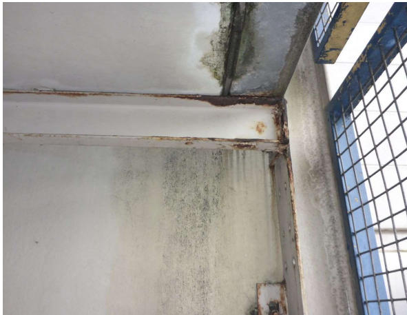
Bild 101 Rampen- und Randträger (B0294)
