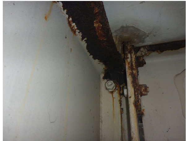
Bild 54 Stützen und Anschlüsse (B0170)
