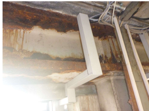
Bild 14 Träger über Einfahrt (B230)
