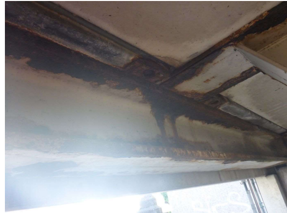
Bild 12 Träger über Einfahrt (B228)
