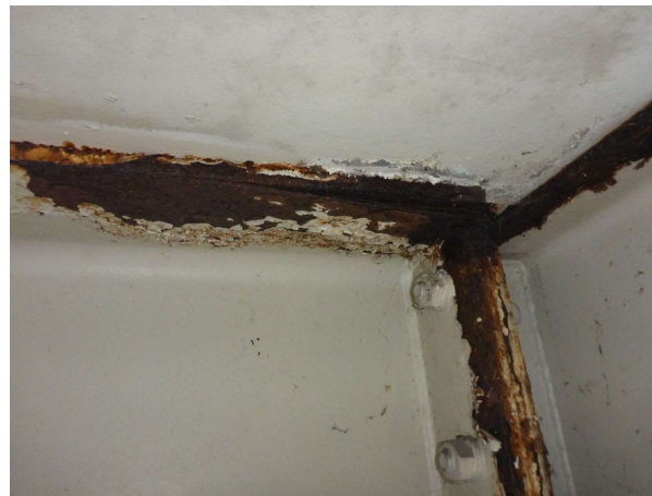
Bild 106 Querschnittsminderung (B0087)
