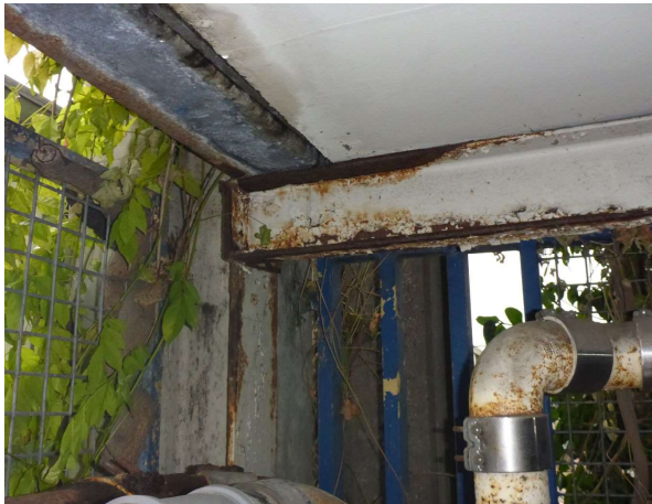
Bild 99 Rampen- und Randträger (B0190)
