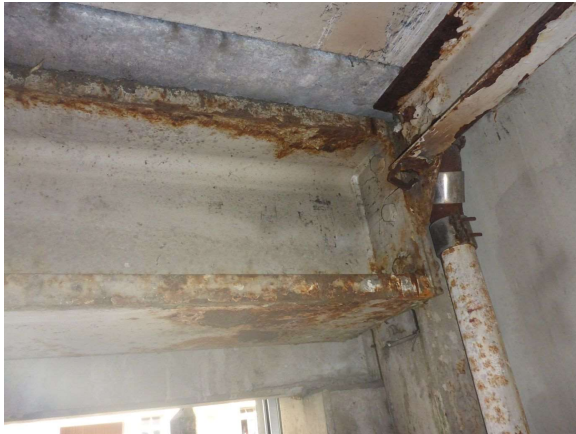
Bild 11 Träger über Einfahrt (B227)
