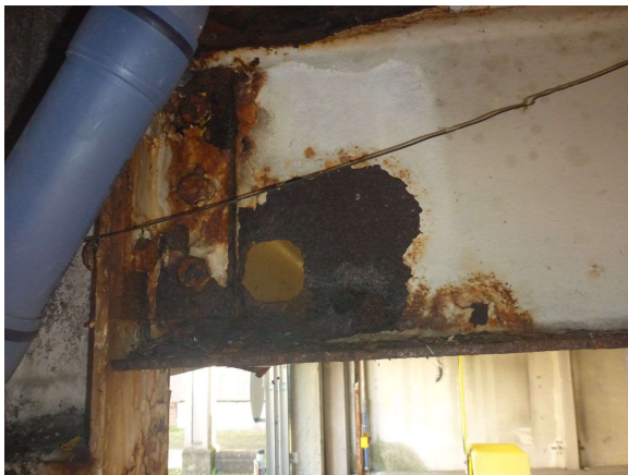
Bild 21 Träger über Einfahrt (B237)
