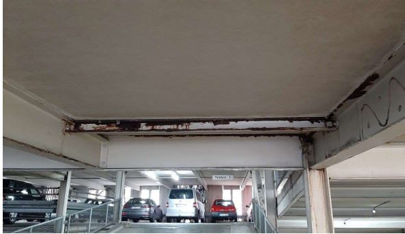
Bild 87 Rampen- und Randträger (B0714)
