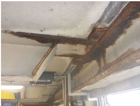
Bild 13 Träger über Einfahrt (B229)
