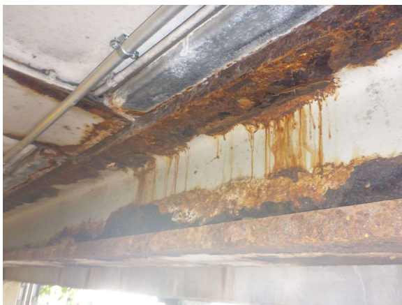
Bild 15 Träger über Einfahrt (B231)
