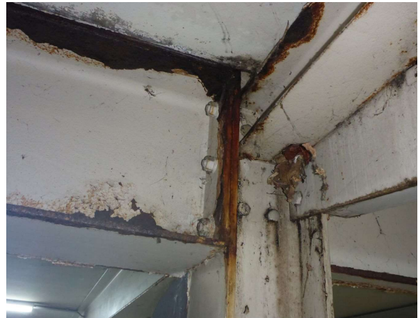
Bild 66 Stützen und Anschlüsse (B0163)
