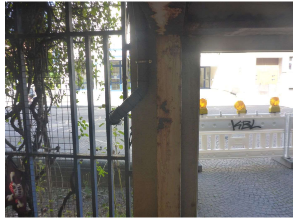
Bild 18 Träger über Einfahrt (B234)
