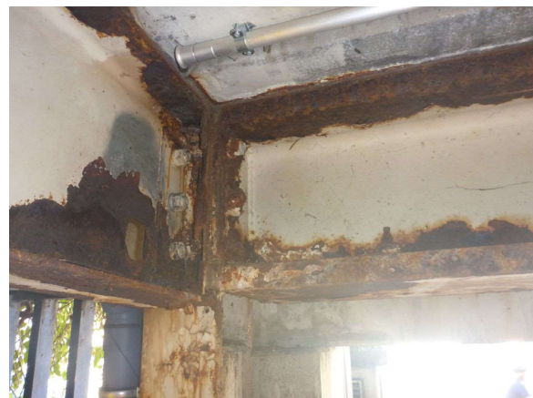
Bild 16 Träger über Einfahrt (B232)
