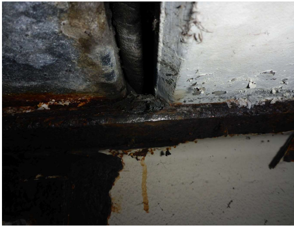
Bild 113 Querschnittsminderung (B0101)
