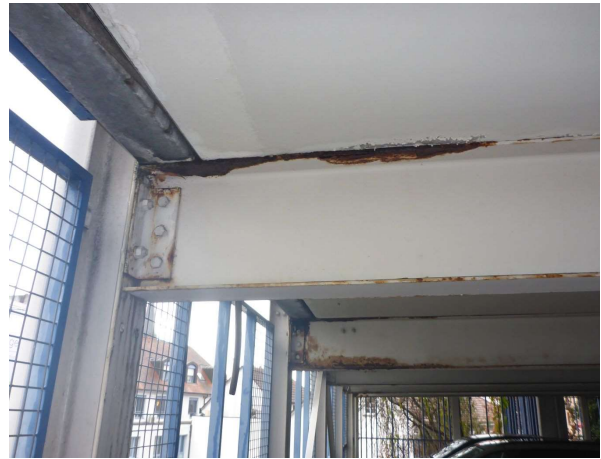
Bild 84 Stützen und Anschlüsse (B0301)
