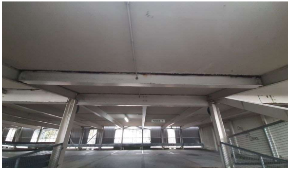
Bild 93 Rampen- und Randträger (B1818)
