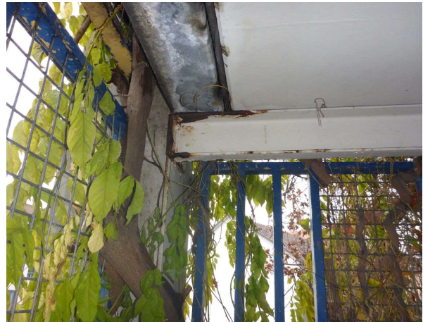
Bild 100 Rampen- und Randträger (B0252)
