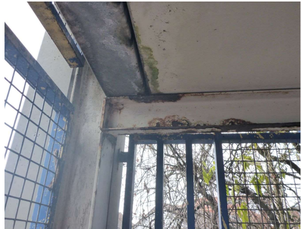
Bild 102 Rampen- und Randträger (B0311)
