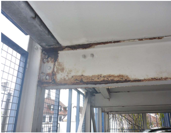
Bild 85 Stützen und Anschlüsse (B0303)
