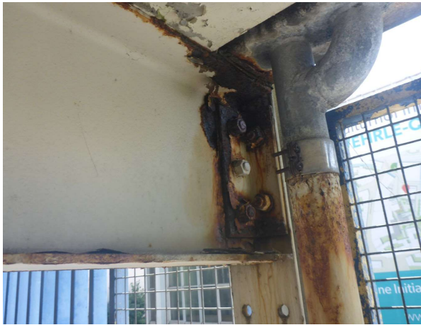
Bild 59 Stützen und Anschlüsse (B0212)
