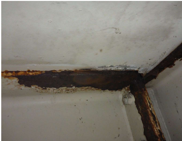
Bild 107 Querschnittsminderung (B0089)
