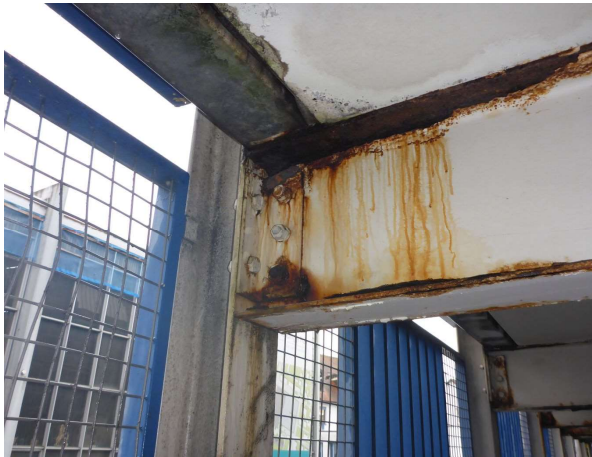
Bild 79 Stützen und Anschlüsse (B0238)
