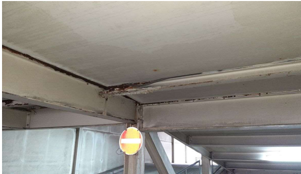
Bild 89 Rampen- und Randträger (B0925)
