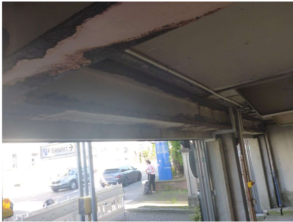
Bild 17 Träger über Einfahrt (B233)
