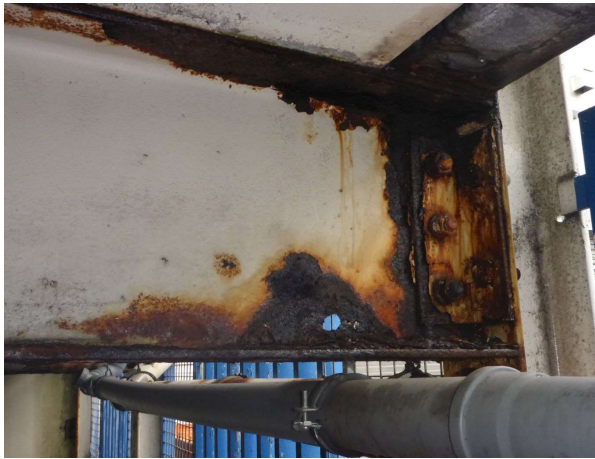
Bild 71 Stützen und Anschlüsse (B0177)
