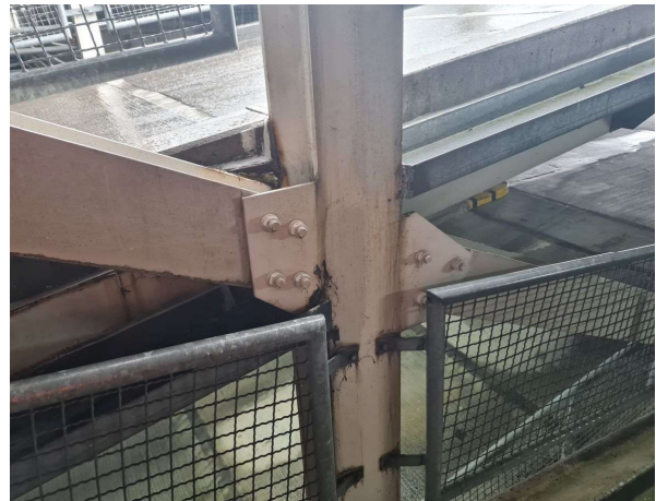
Bild 96 Rampen- und Randträger (B4336)
