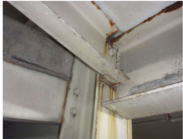
Bild 78 Stützen und Anschlüsse (B0223)
