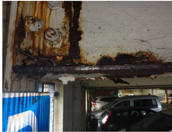
Bild 114 Querschnittsminderung (B0102)
